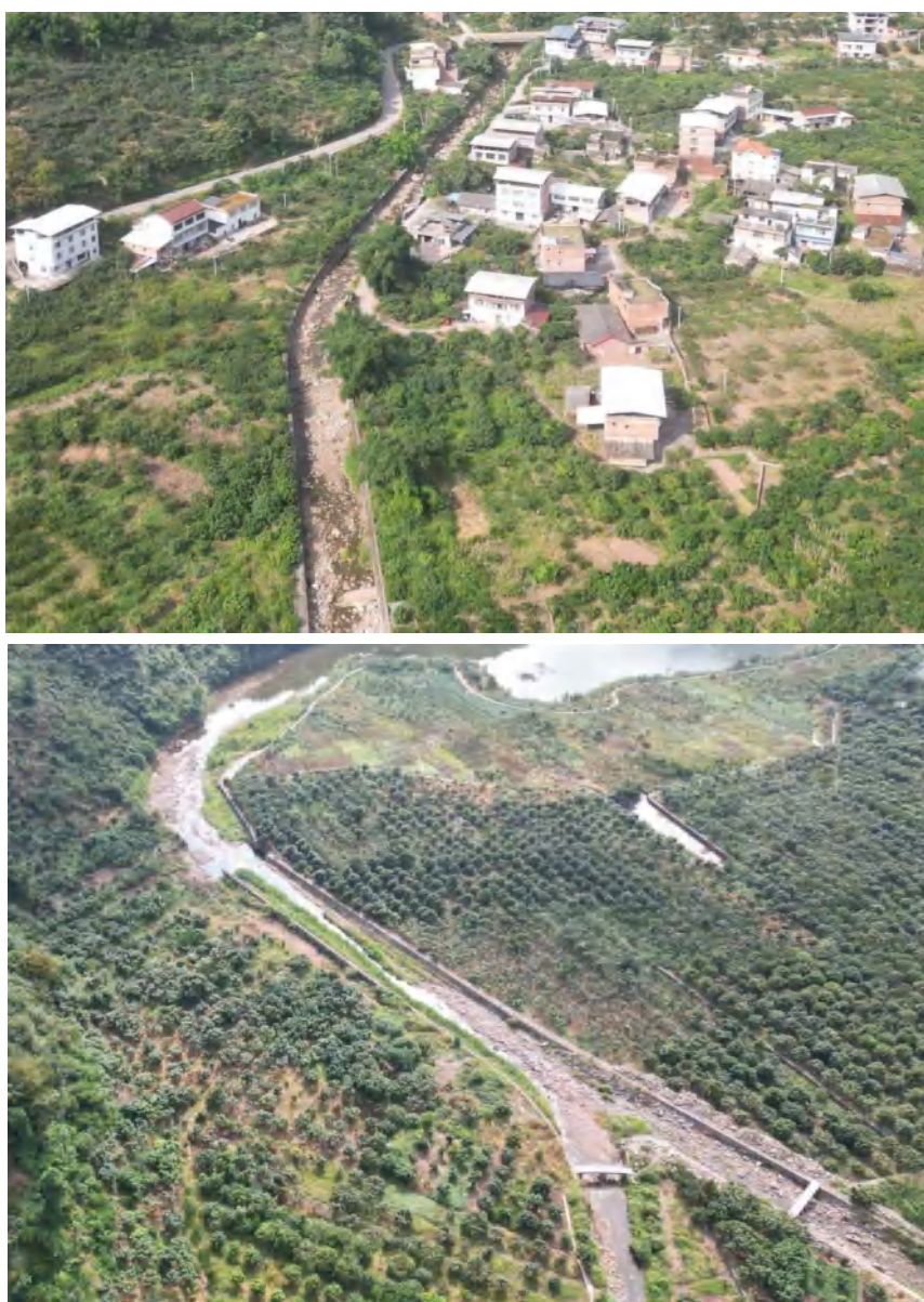
图 2.3-2 楠木沟流域下游已成防洪治理工程
