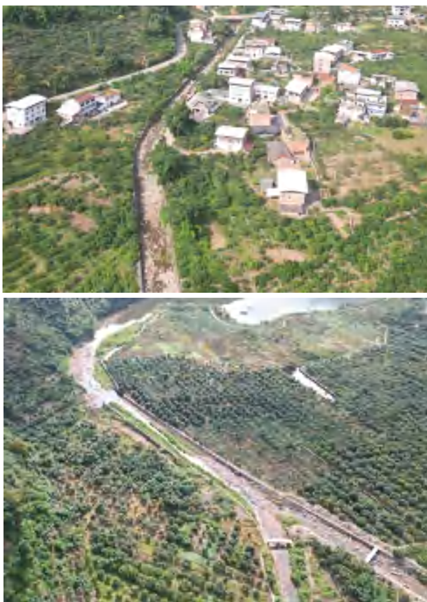
图 2.3-2 楠木沟流域下游已成防洪治理工程
